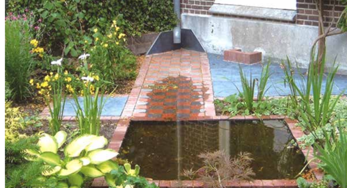
Geef een watergoot naar de infiltratieplek lichte afstroming. Water stroomt van hoog naar laag
