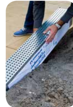
Geef een watergoot naar de infiltratieplek lichte afstroming. Water stroomt van hoog naar laag
