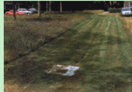
Verlaagde berm t.b.v. waterafvoer
