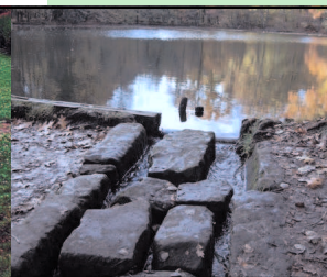
via een waterlozelement stroomt het water uit de goten in de retentievijver
