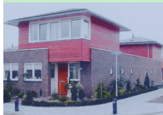
Referenties architectuur noordelijke deel fase 1
