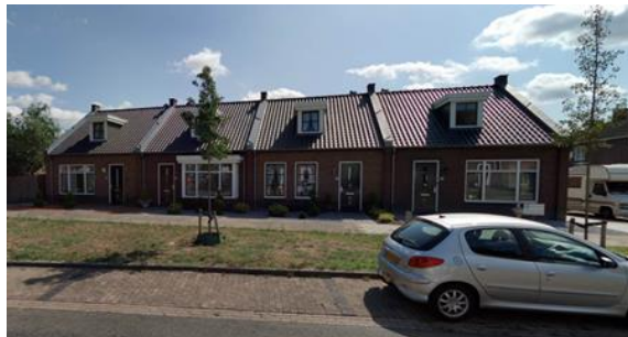
Multifunctionele woningen Destion in Nieuw Bergen.
